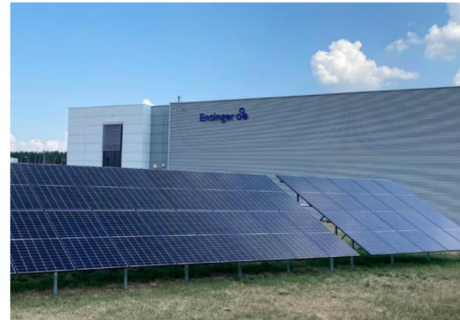
Ensinger nutzt verstärkt Elektrizität aus eigenen Photovoltaik-Anlagen. Bereits heute beträgt die in Deutschland installierte Leistung 750 kWp. Aus drei Anlagen werden so jährlich knapp 360 MWh Strom erzeugt. Eine weitere Anlage mit einer Leistung von 930 kWp befindet sich auf dem Werksgelände des Standorts Cham im Bau.
